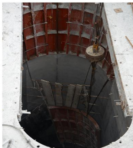
图3 9#桥墩内部俯视图(事故后)
