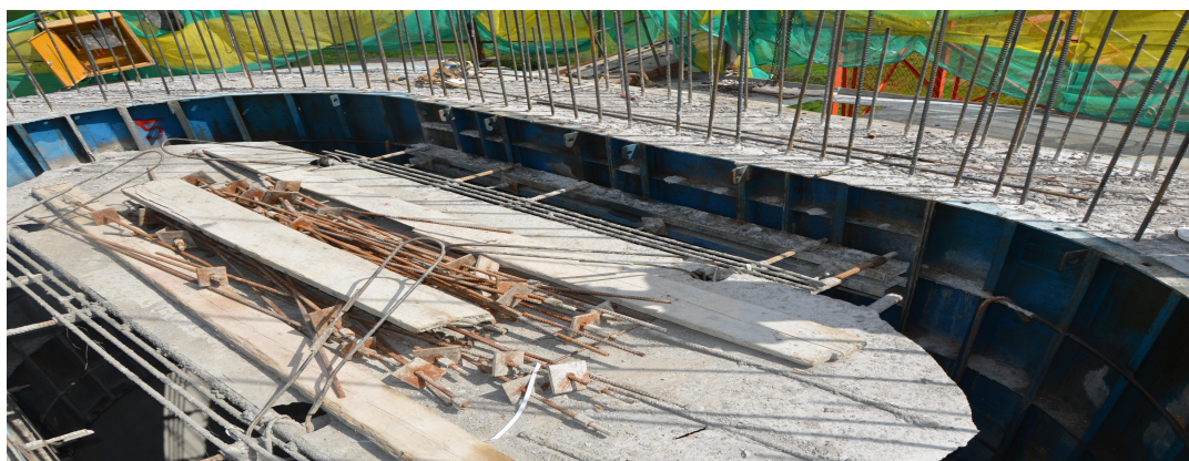
图5 其他施工段桥墩内部作业平台
