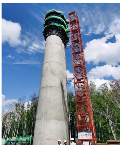
图2 三莲山特大桥9#桥墩
