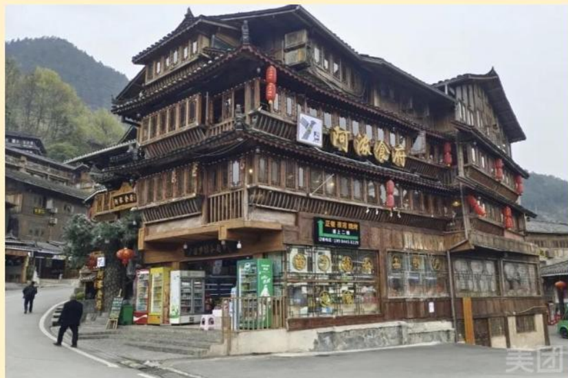
图 1: 火灾事故发生前建筑物外观图
