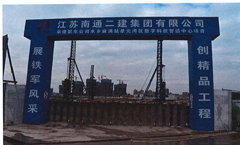
图 7 现工地临时大门安装位置
