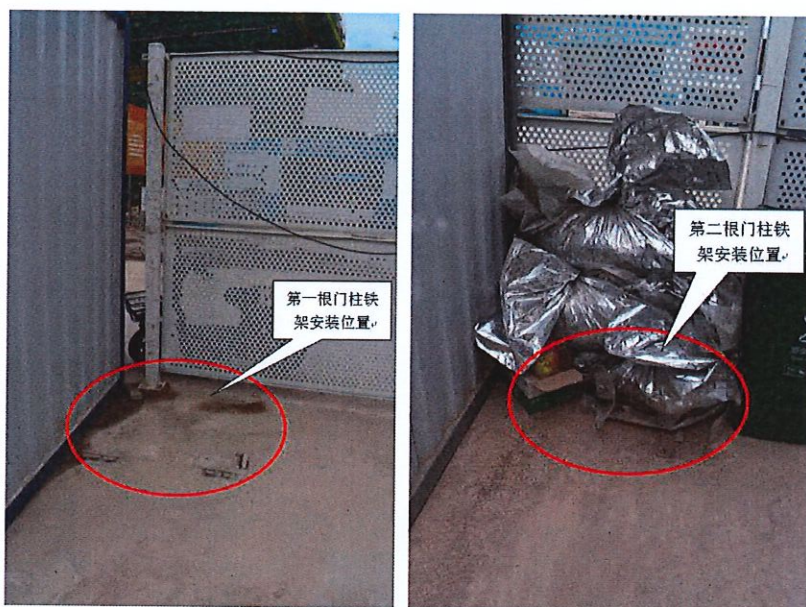
图 5 红圈为原两根铁架安装预埋件位置
