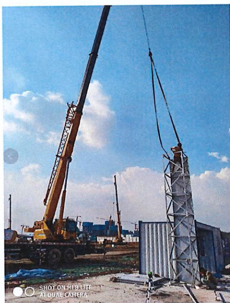
图 5 门柱铁架安装方法（刘博学摄）
