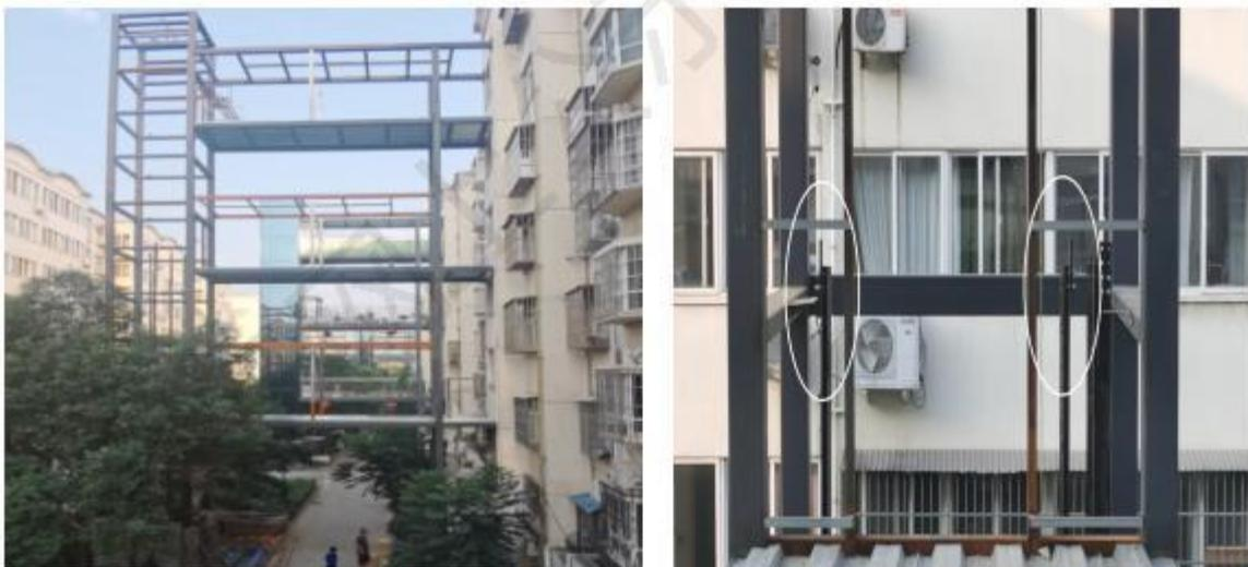
经现场勘查，安装工程的基础、基坑和钢结构施工已完成，现场全部钢构呈裸露状态。电梯导轨已安装至第 4 层。对重块、驱动主机、控制柜、门机、轿厢门、层门及门套、限速器、缓冲器、呼梯盒、曳引钢丝绳、通讯电缆等均未安装。
