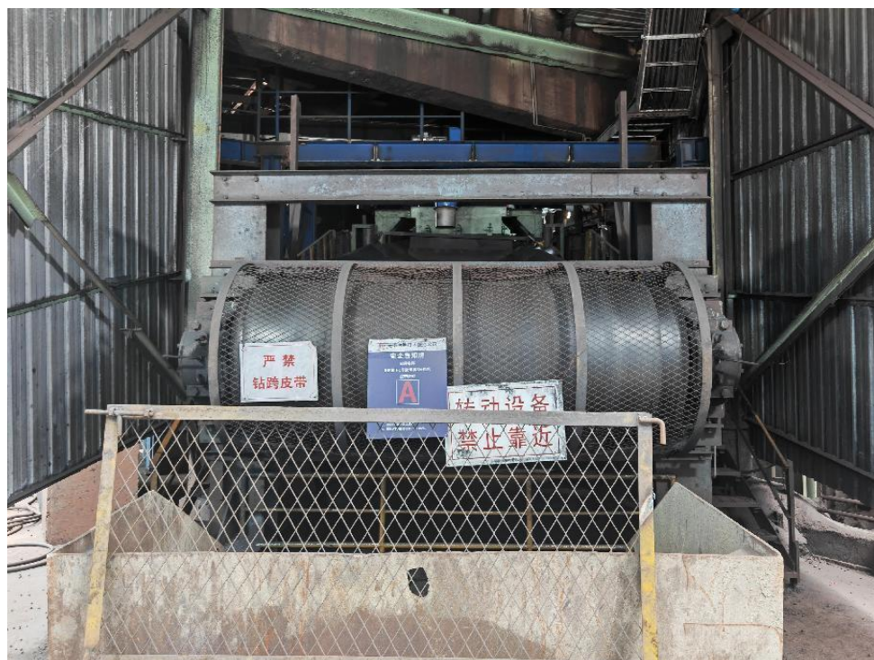
图 2 B 高炉槽下 1 号皮带机尾轮
