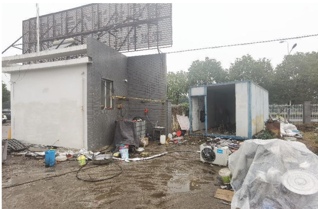
图1 贾某策洗车点未拆除的临时用房及洗车设备
