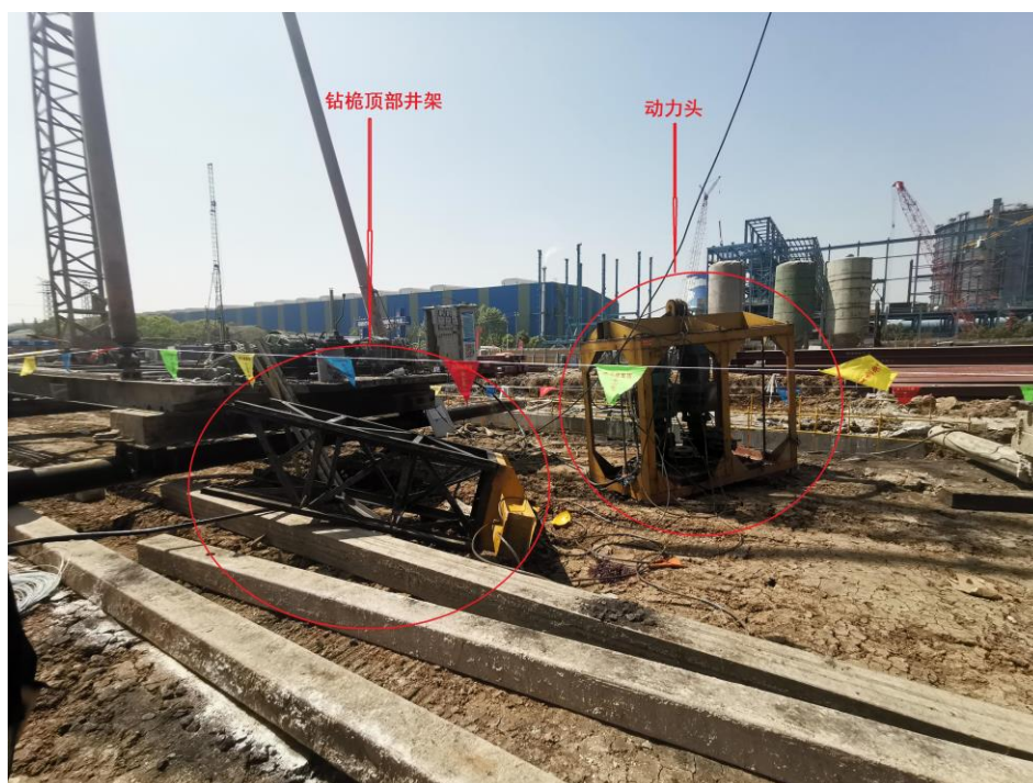
图三 断裂坠落的自制“标准节”与动力头
