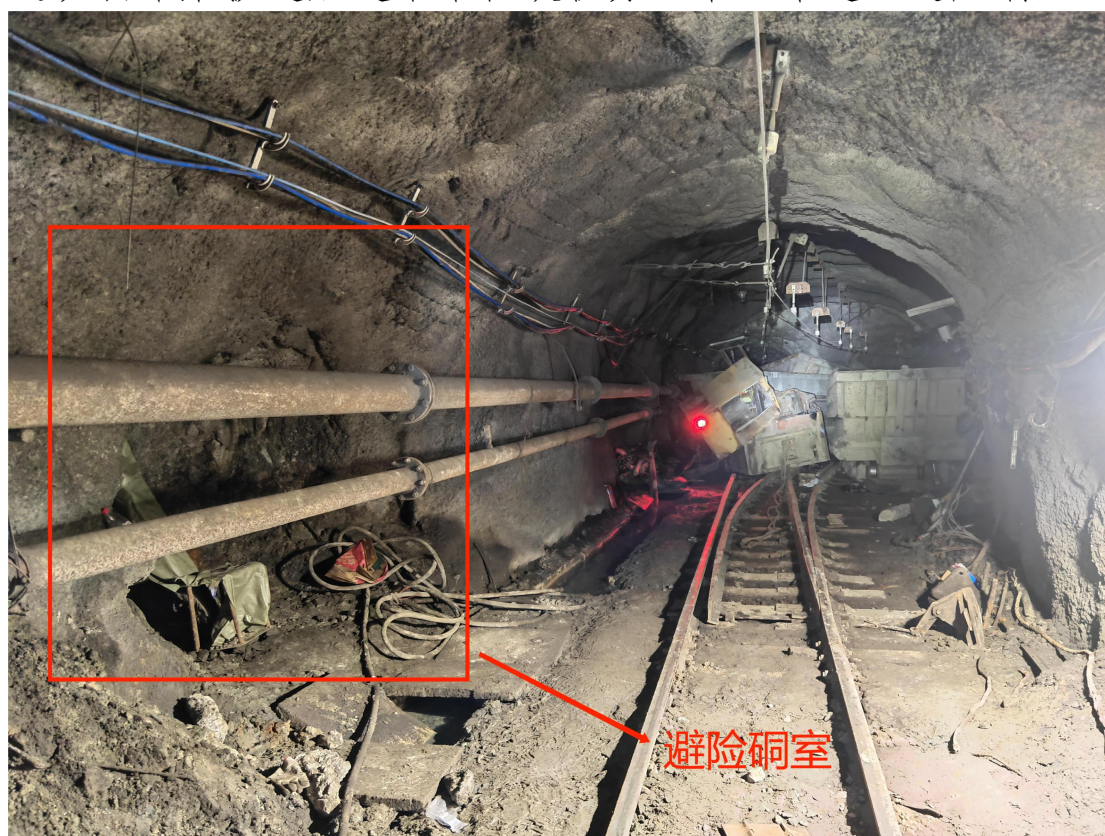
图 12 3#穿脉交岔口处避险硐室
