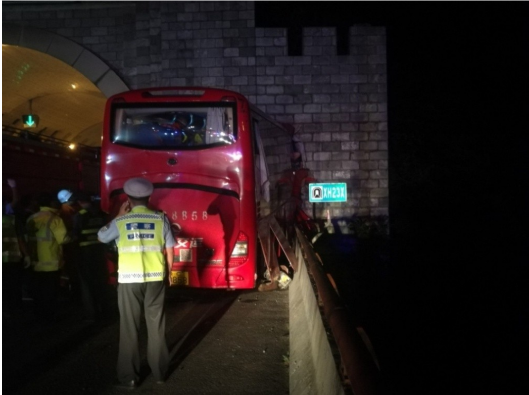
图 3 车辆碰撞隧道口情况
