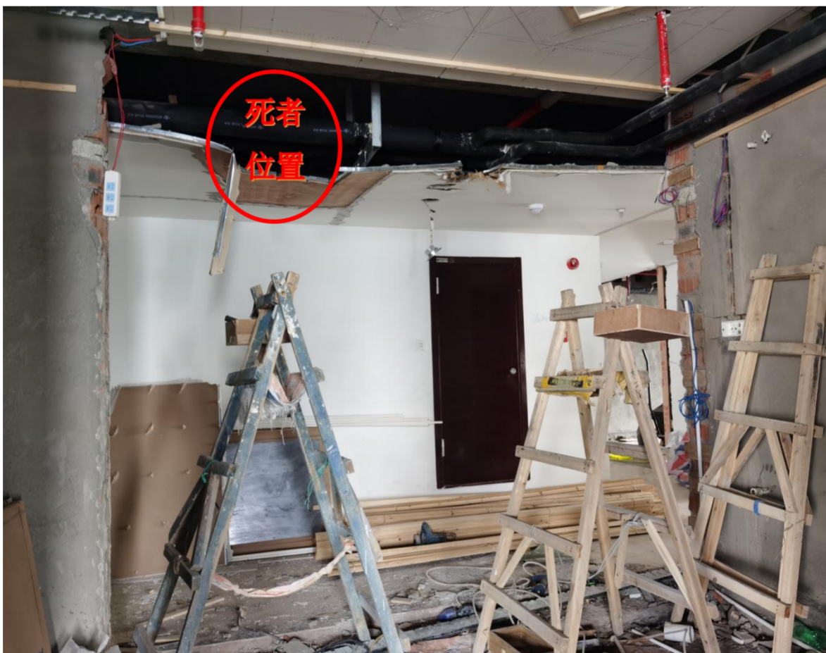
（图 1）明城商务广场 21 楼装修施工现场
