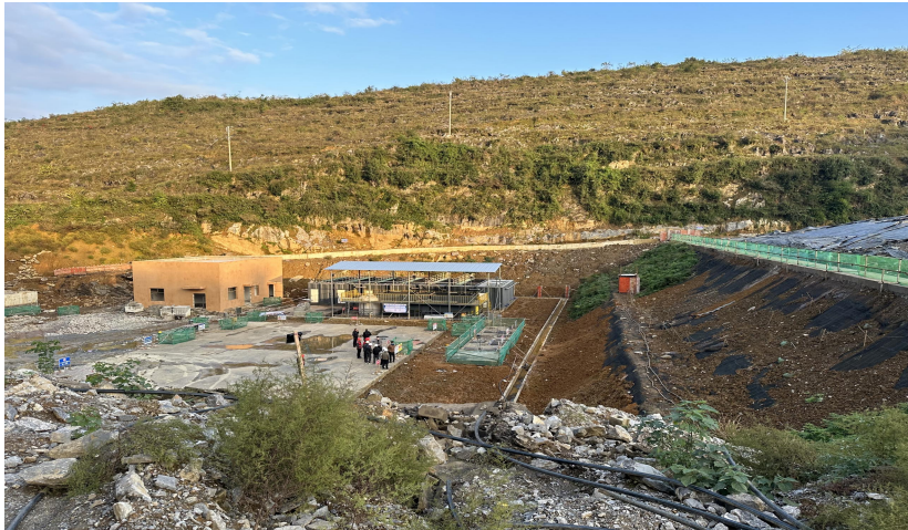
图 2：事故现场概貌
