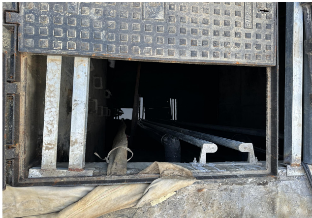
图 5：事故现场渗滤液阀门井
