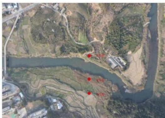
图 4 施工现场俯视图
