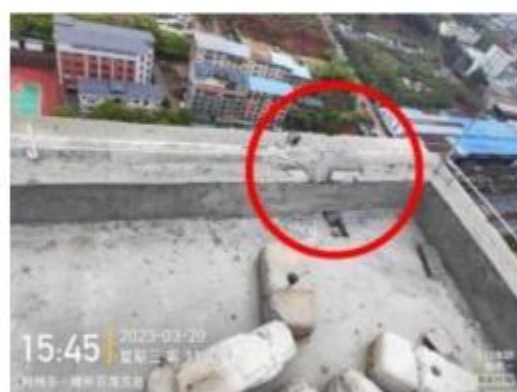
图 9 东侧悬挂装置搁置点
