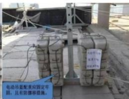
图 13 配重采用钢丝绳可靠固定图例
