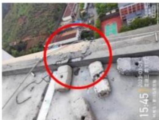
图 8 西侧悬挂装置搁置点
