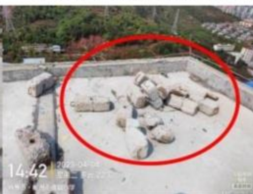
图 15 东侧悬挂装置配重散落位置图
