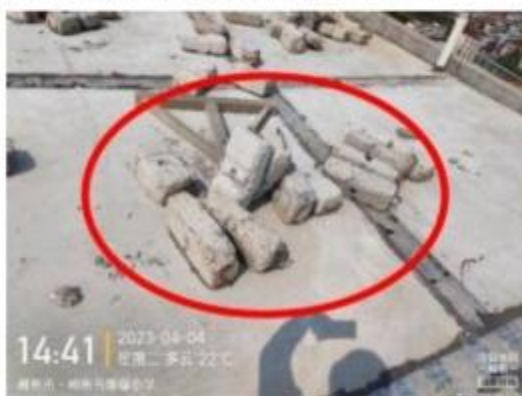
图 14 西侧悬挂装置配重散落位置图
