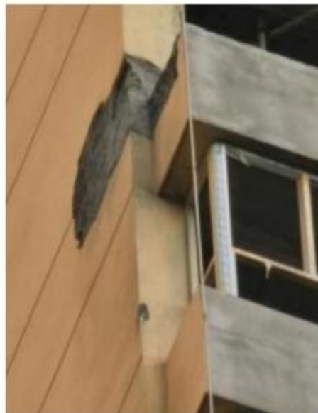
图2 14层位置作业面现场图
