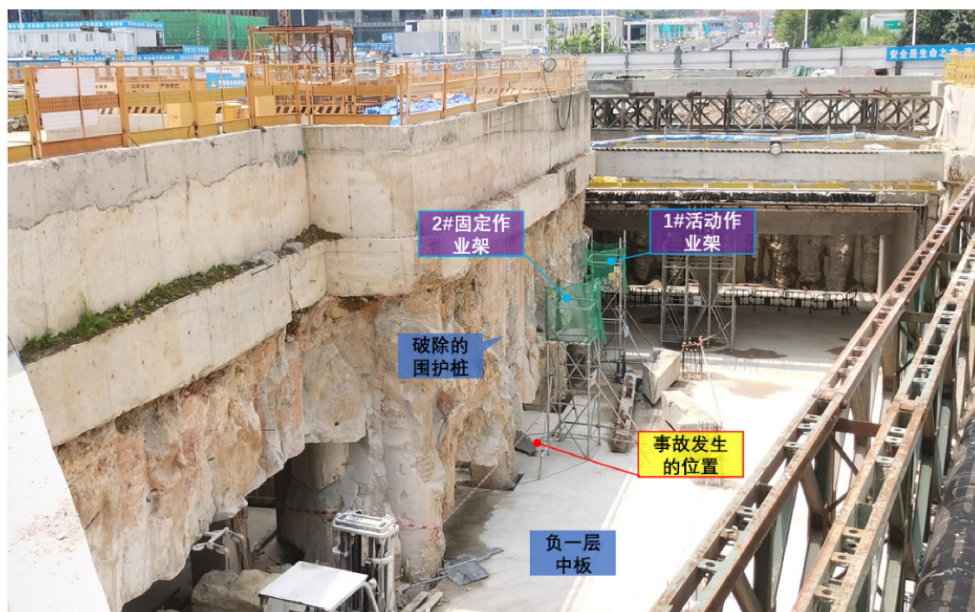
图 2：1 号风亭组负一层结构中板区域
