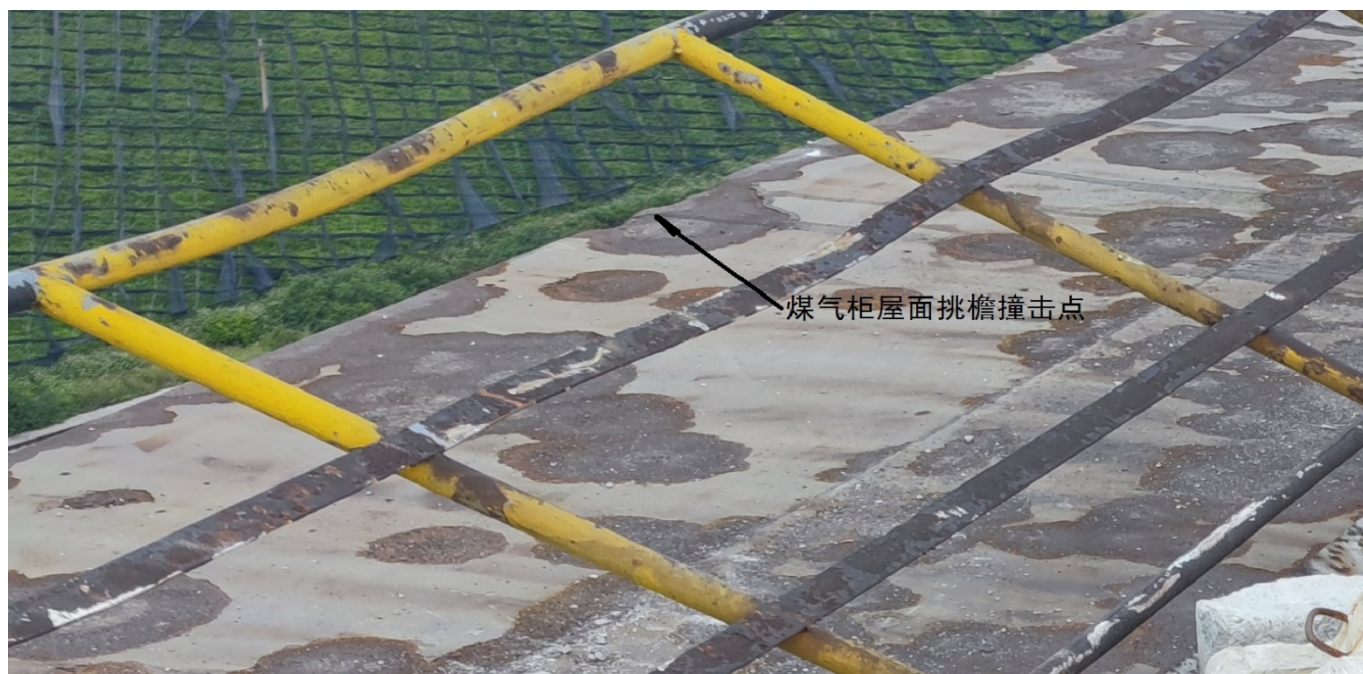
图 7：2 号吊篮左边（面向煤气柜）悬挂机构后立柱移位时与煤气柜顶的摩擦痕迹
