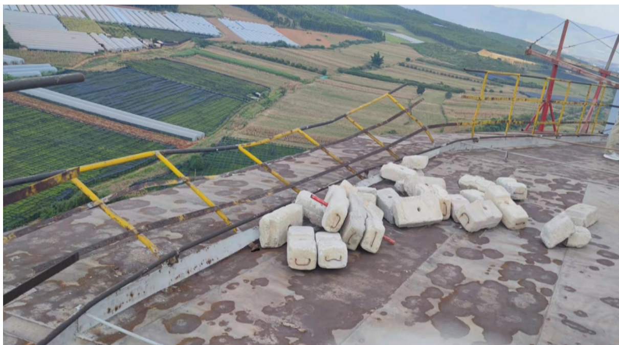
图 9：2 号吊篮煤气柜顶遗留下左端（面向煤气柜）悬挂机构部分配重重块
