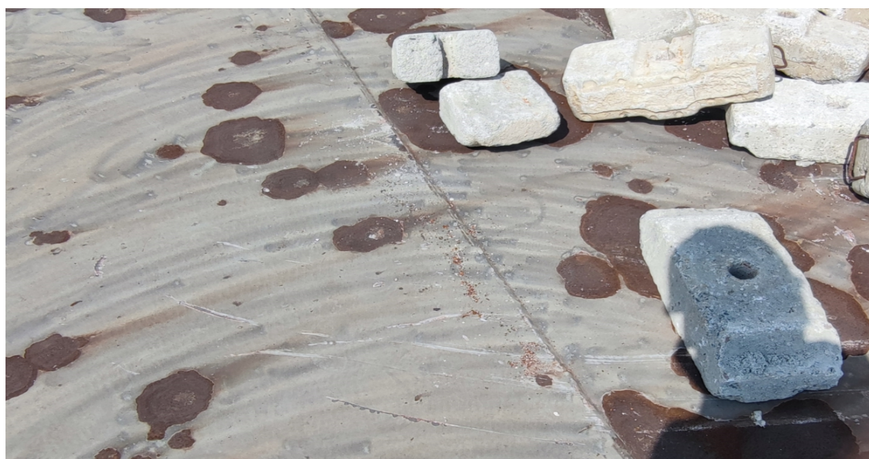
图 7：2 号吊篮左边（面向煤气柜）悬挂机构后立柱移位时与煤气柜顶的摩擦痕迹
