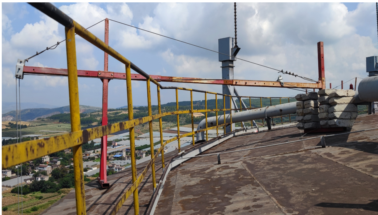
图 2：1 号煤气柜斜面屋顶安装的悬挂机构
