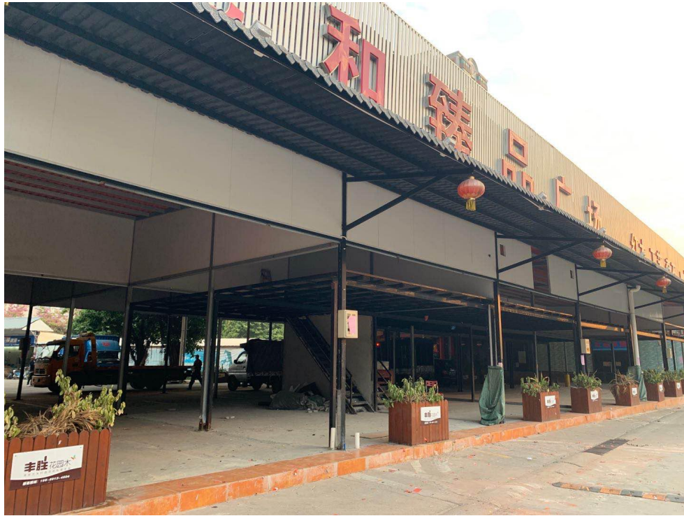
（图2 停车场东侧空置商铺，拆除前概貌。）
