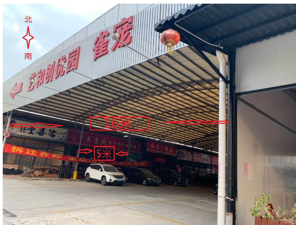
（图 1 艺和广场中心停车场及顶上棚架，拆除前概貌。）
