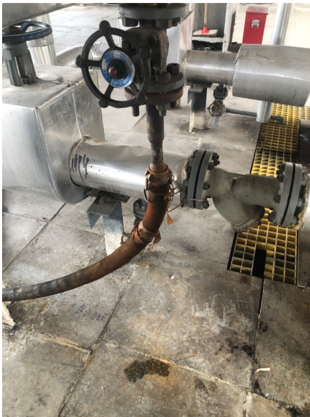
图5 事发现场铝合金阴阳快接卡口及软管
