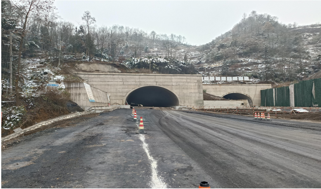
图 2 纳晴高速公路项目 T8 标段后寨隧道（事发隧道）
