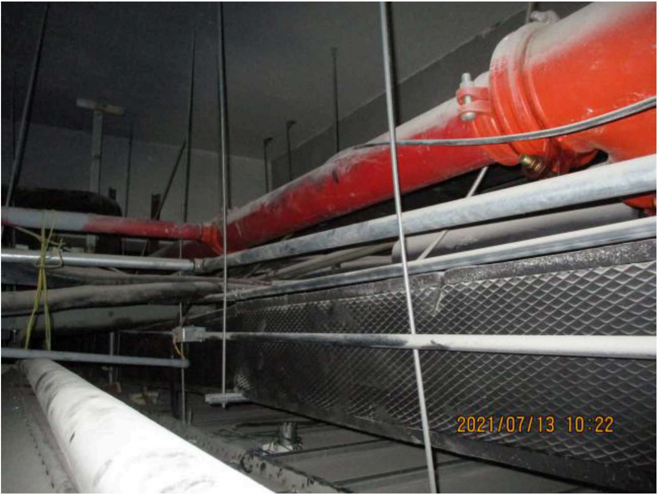
图2：天花板夹层内部情况
