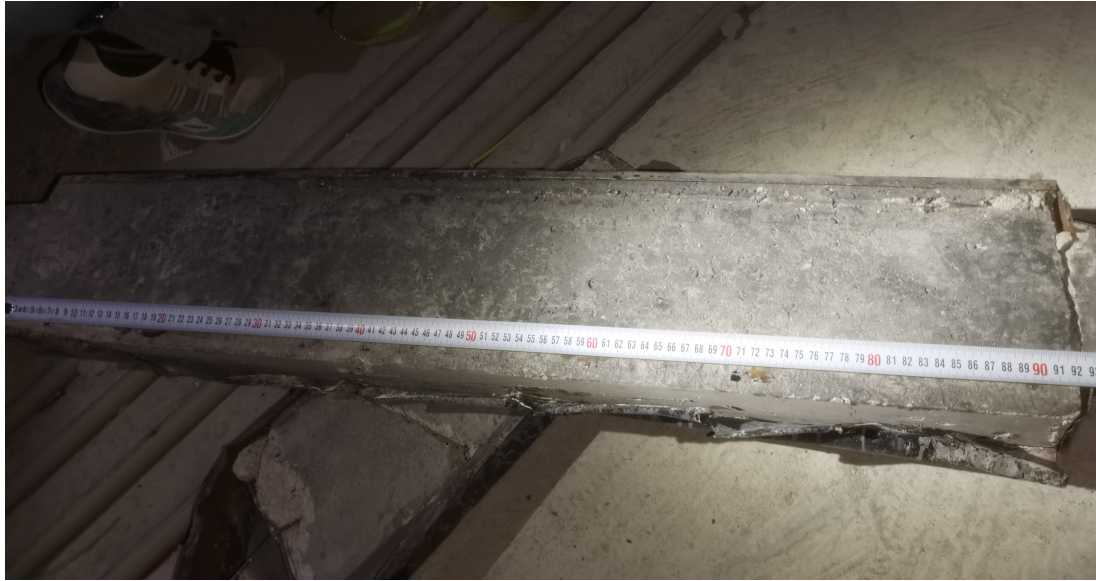
图 6 坠落对重块情况
