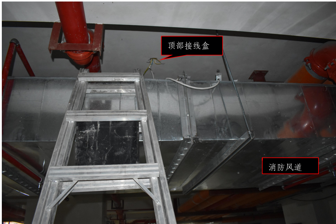
图4 负二层顶端接线盒位置图
