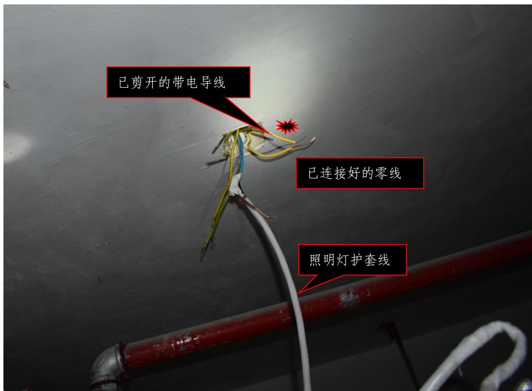
图 8 已连接的导线情况图
