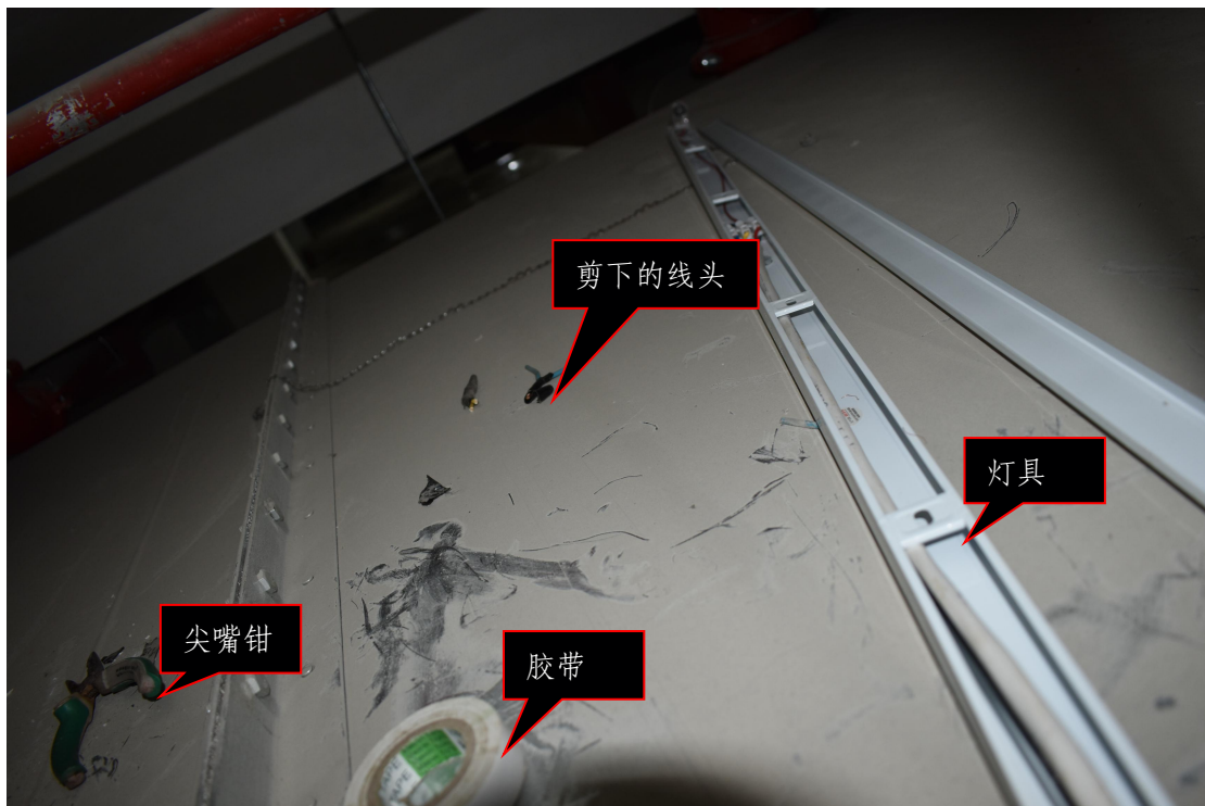
图5 消防风道上摆放的工具材料
