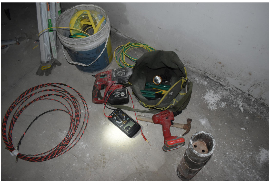
图 7 现场北墙放置的作业工具、材料图
