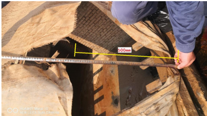
图13 斜网穿破孔中心尺寸
