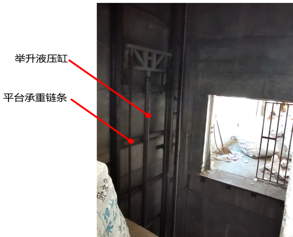
图二：设备提升装置情况
