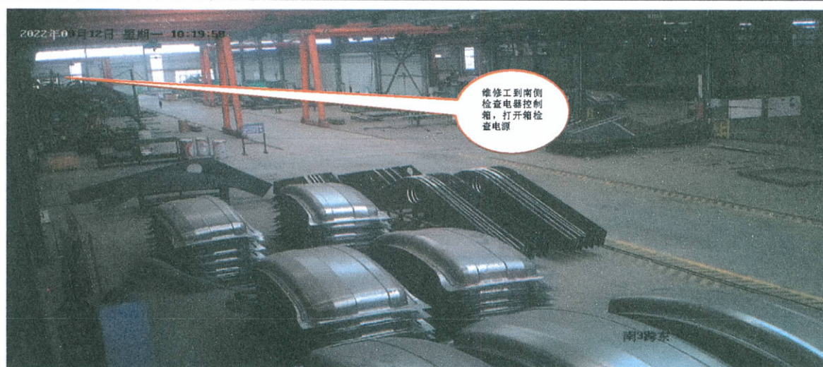
图片 2：10 点 19 分 58 秒，维修工检查起重机控制箱查看电源
