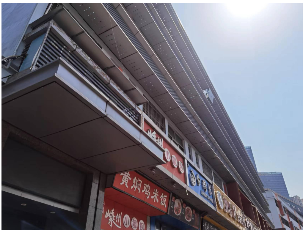
威宇隆产业园 A 栋厂房
