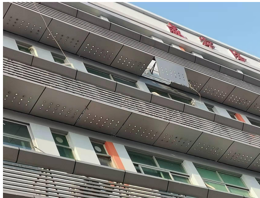
踩破的外架单片金属底板
