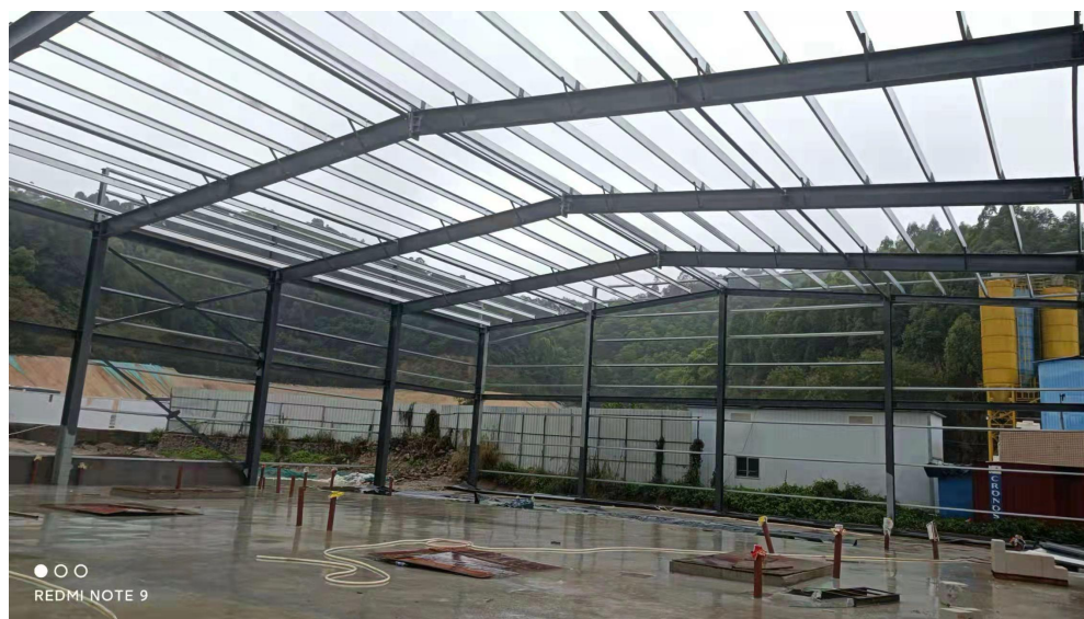
安装檩条区域相片
