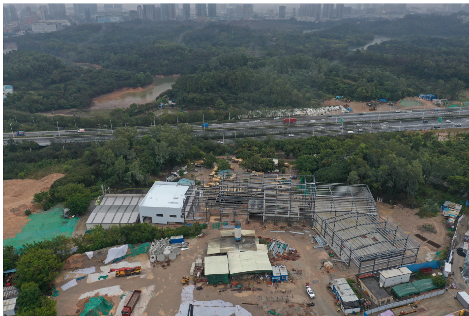
炉渣制砖车间鸟瞰相片
