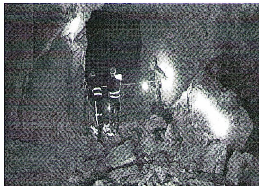
图5 2号进路入口处冒落的矿、岩
