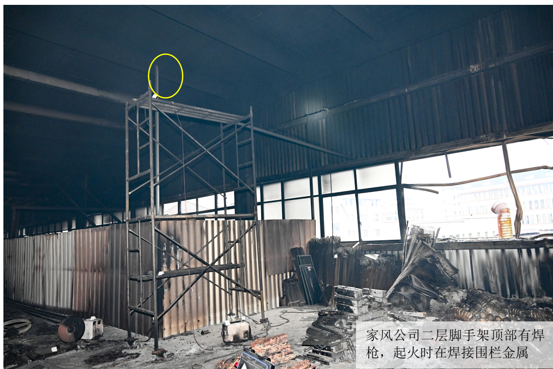
图四：家风公司二楼电焊作业现场
