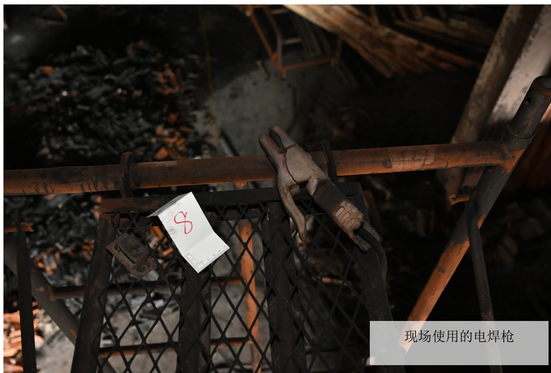
图五：家风公司二楼电焊作业现场
