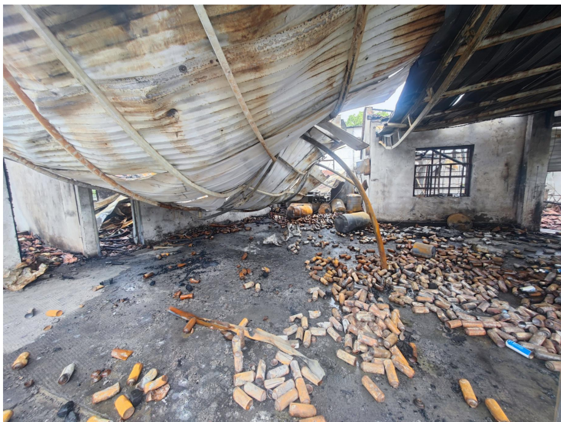
图 4 作业现场北侧情况
