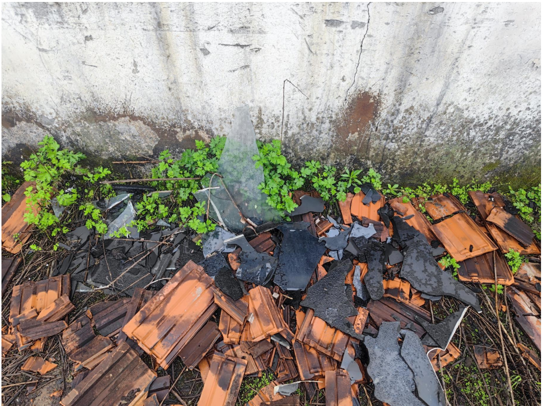
图 7 窗户玻璃破碎散落情况
