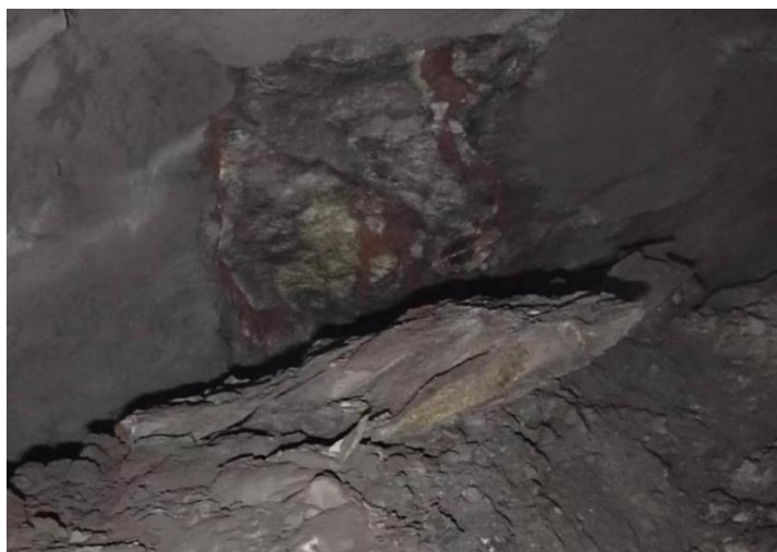
图 2 现场冒落的矿岩图
