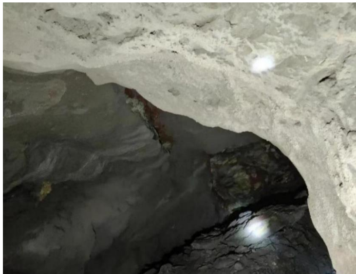
图 1 喷浆支护图
