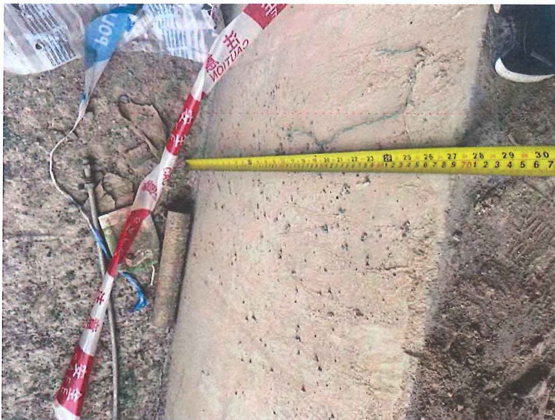
图 6 电梯井基坑尺寸测量
