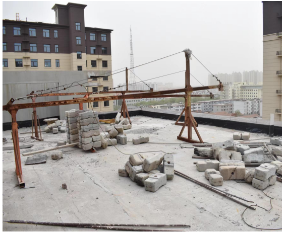
图 3 屋顶悬挂机构图
