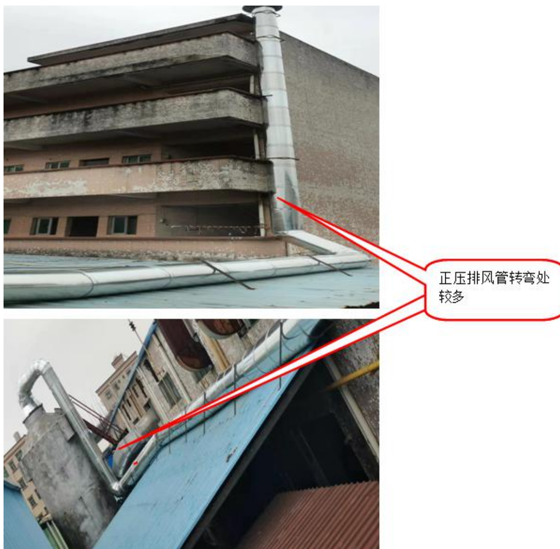
图 4 厂房外排气管安装情况
