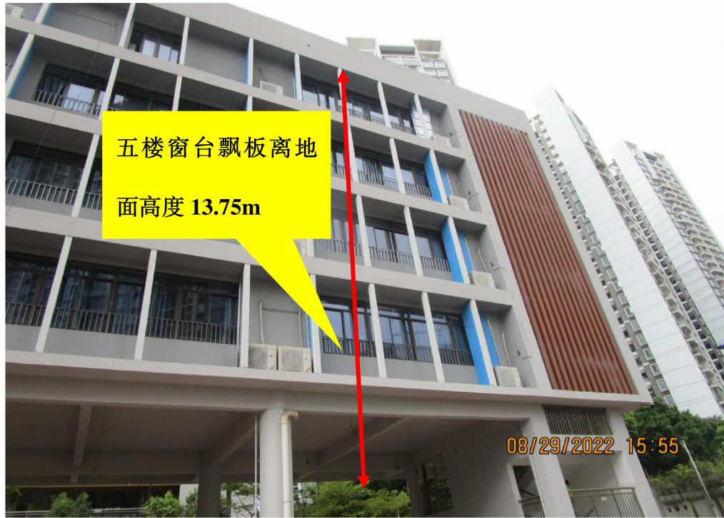
图 4：事发现场窗台
