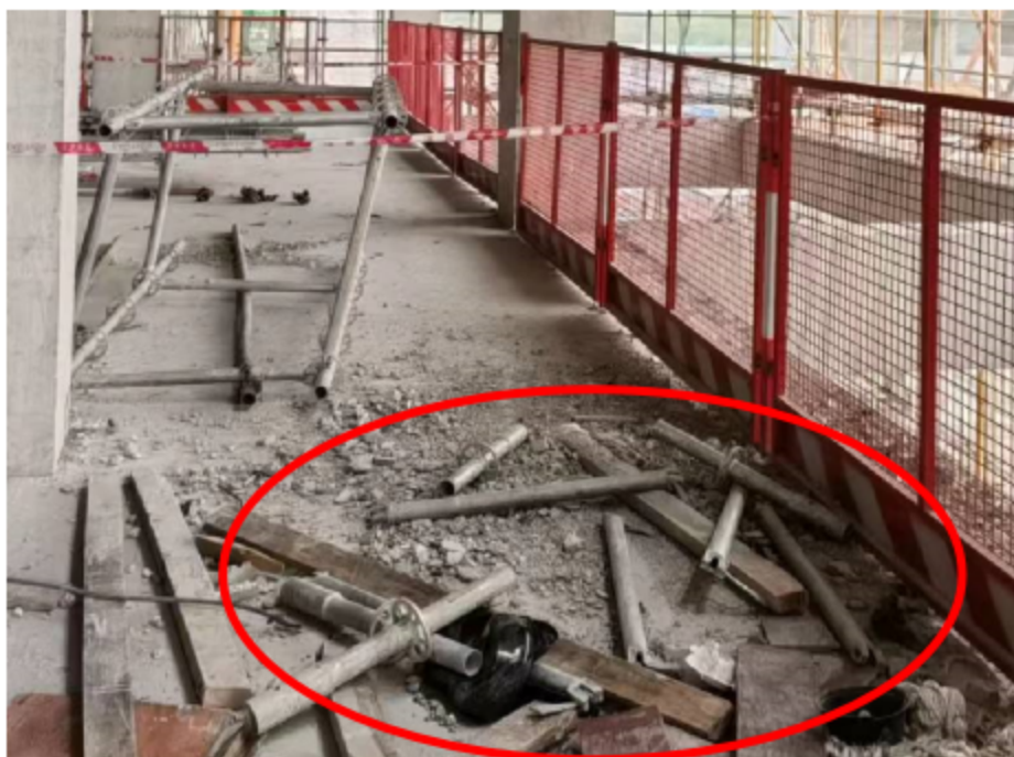
图8 用电操作平台加高构件
