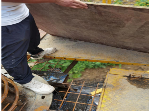
4."5·31"一般高处坠落事故操作平台爬梯孔实景图
