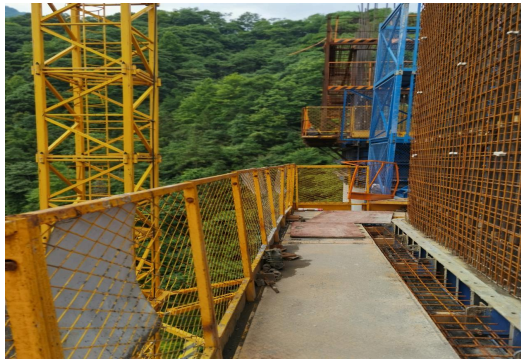
4."5·31"一般高处坠落事故操作平台爬梯孔实景图
