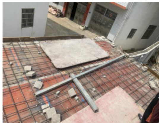
图4 工作间屋顶安装的模板及钢筋
