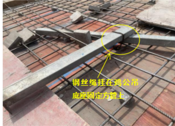
图6 钢丝绳另一头穿过屋面挂在鸡公吊底座方管上
