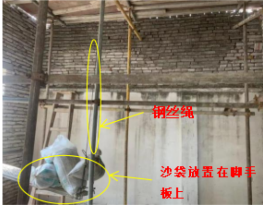
图5 钢丝绳一头绑扎在压有黄沙袋的脚手板上
