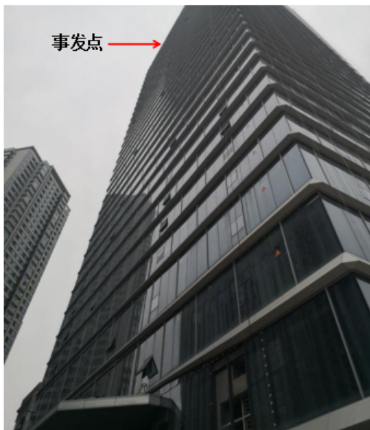
图 1 18#办公楼西侧全貌
