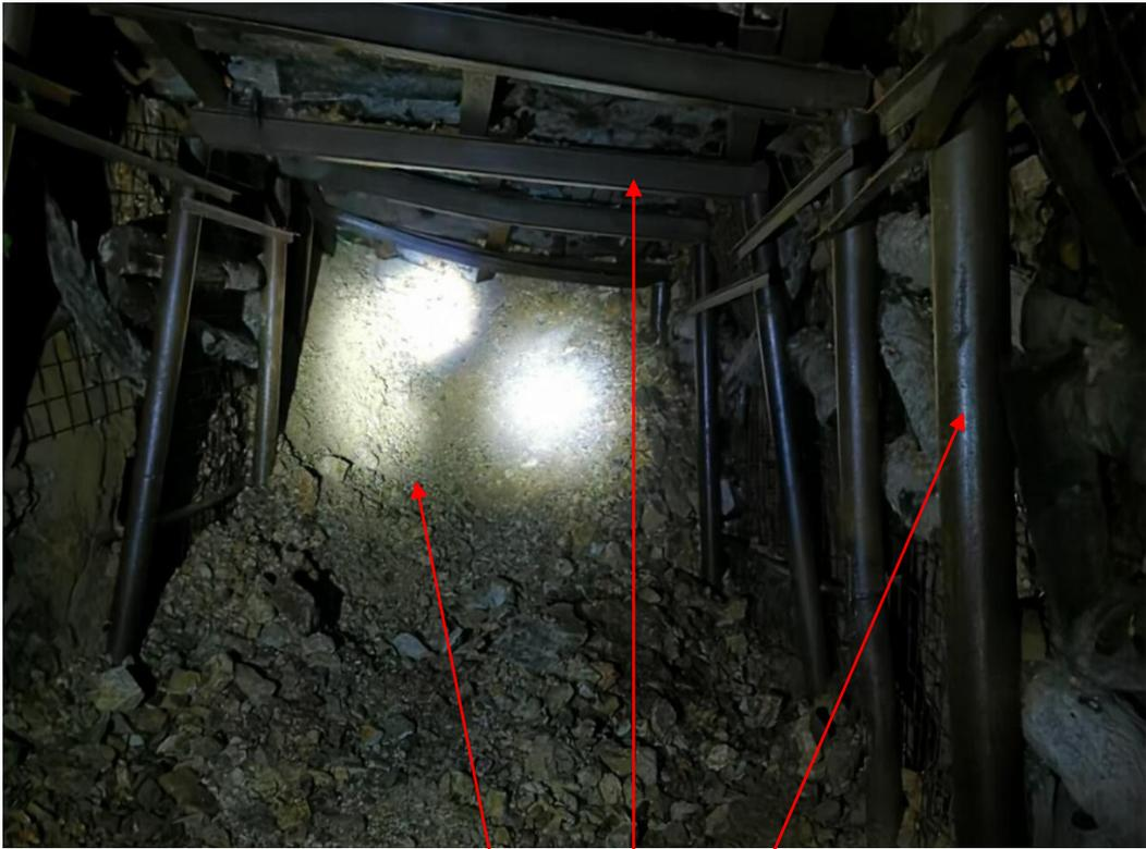
图3 作业点处的废碴、型钢和圆钢管支护
