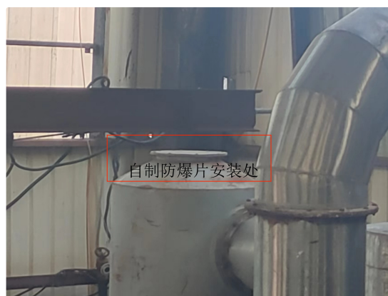
图7 涉事设备顶部自制防爆片
