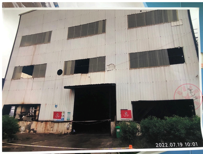
图1 事故车间外貌
