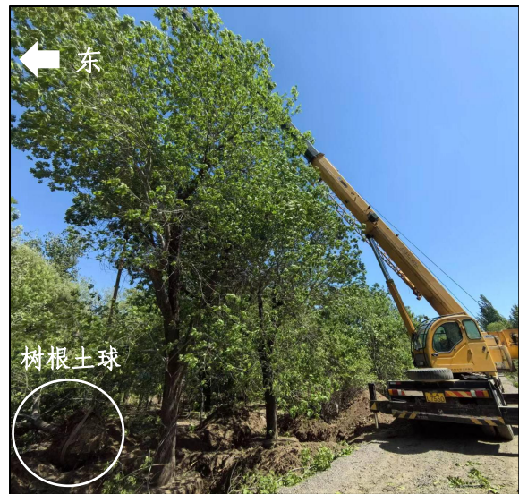
图 2 吊装作业现场
