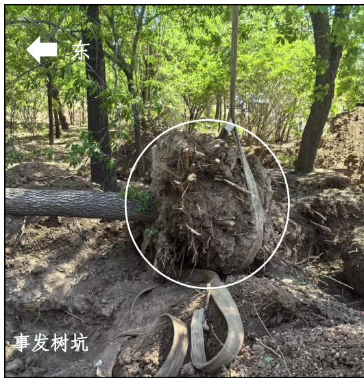
图 1 吊装带围扎的树根土球
