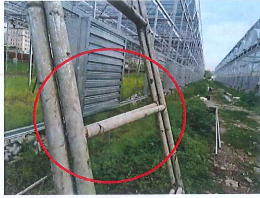
图 5、自制人字梯无防滑装置
