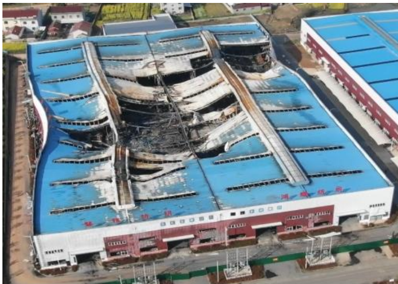
图3 事故厂房外立面
