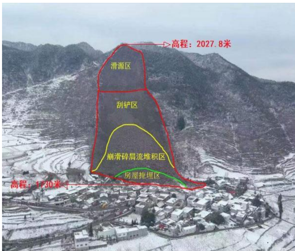
图 8：昭通市镇雄县“1·22”滑坡影像图
