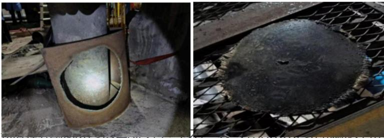
DN630×8mm 水管封堵钢板下料图
