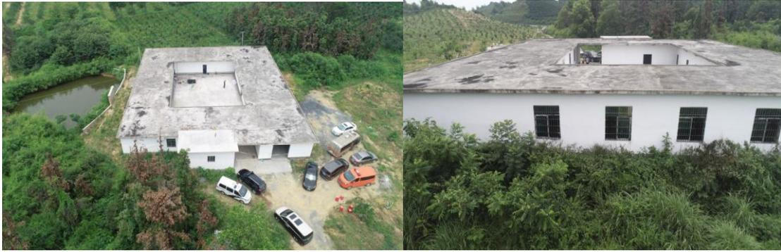
图 1.5、1.6 建筑东西两侧外墙门窗洞口无烟熏痕迹
