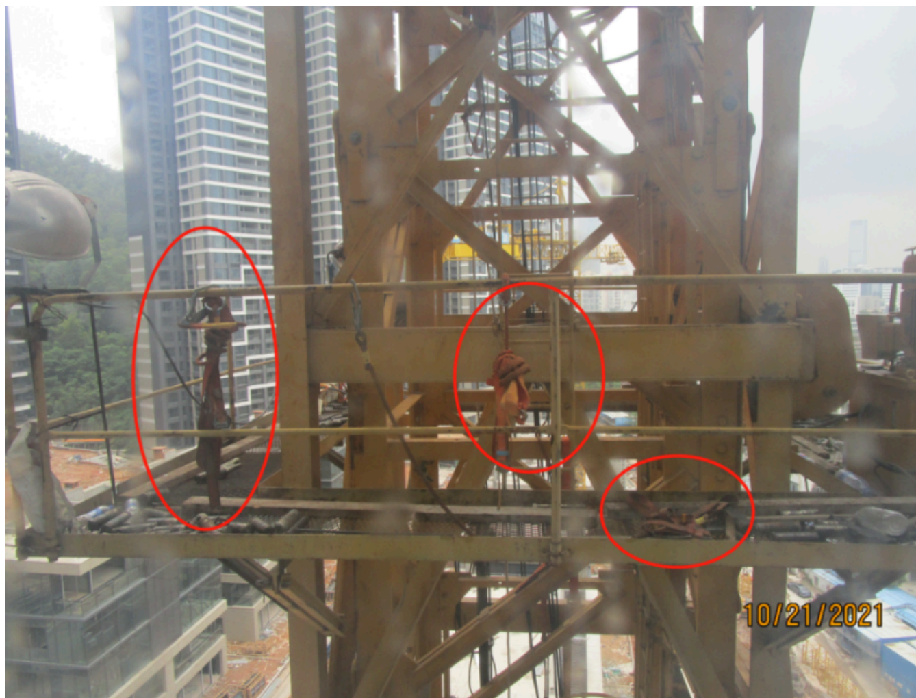
图2：塔吊套架作业平台及安全带
