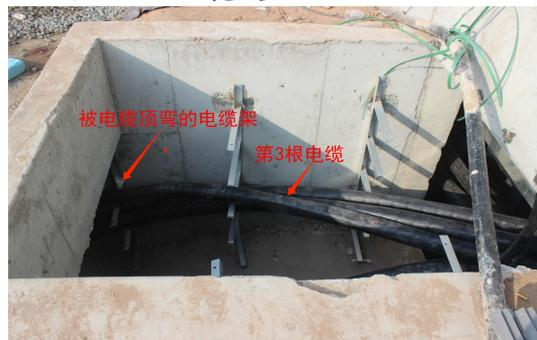
图 20 西侧沟壁运行受阻的电缆
