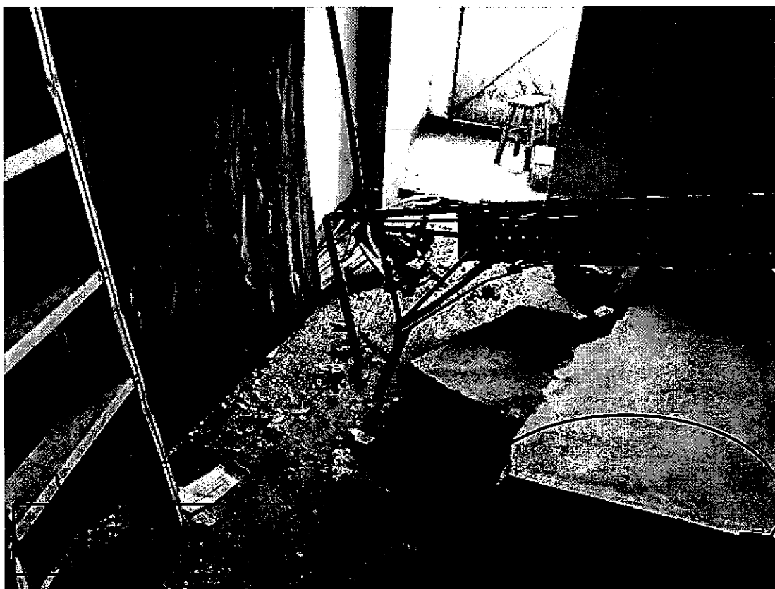
图八 坍塌墙体顶部无冲钻痕迹，并与天花板贴合
