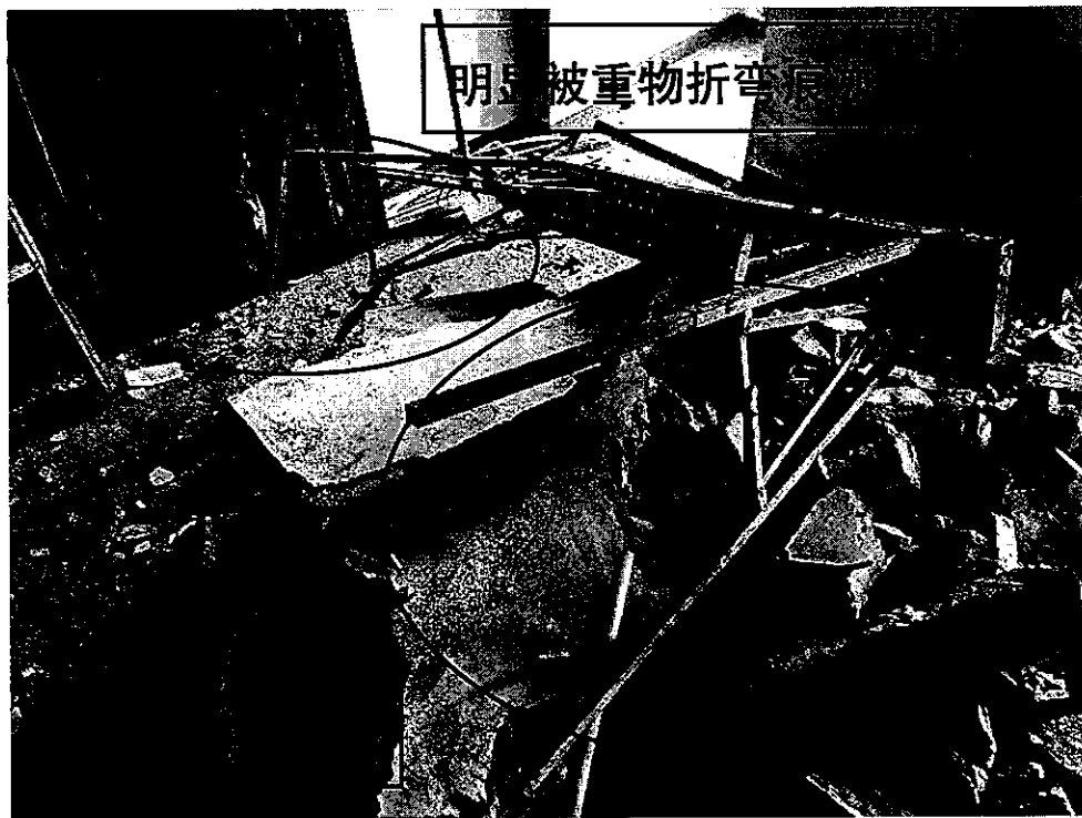
图七 事故现场的梯架
