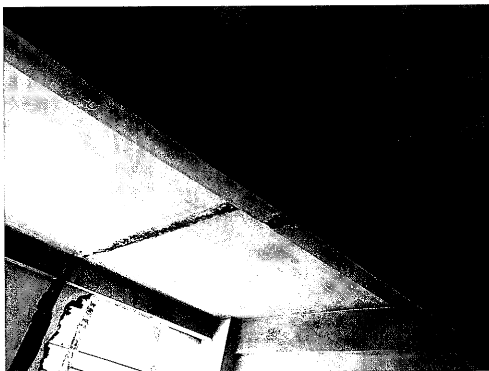
图三 涉事房屋天花板与隔墙连接，痕迹明显
