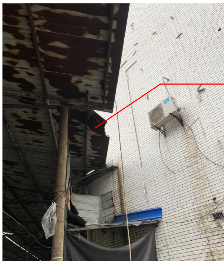
图 1 发生事故点位钢架支撑位置变化
